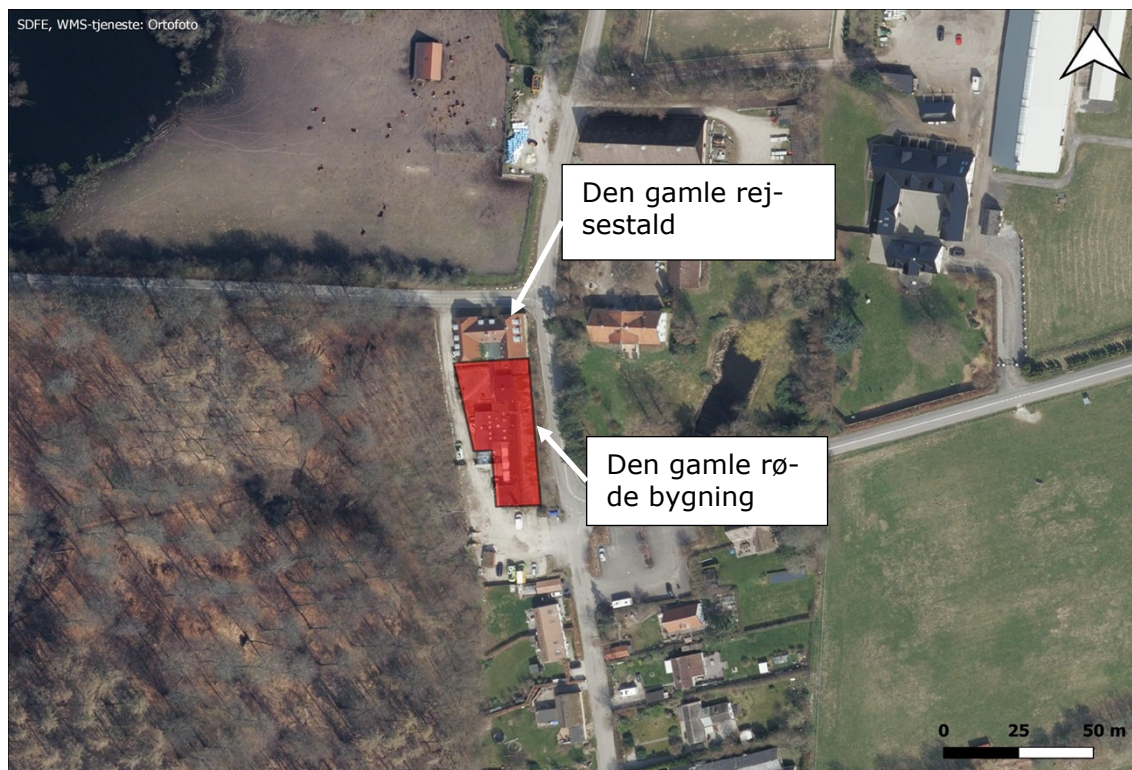
Figur 1: Oversigtsfoto over Bregnerød Kro. Den gamle røde bygning er markeret med rød, da den skal nedrives.
