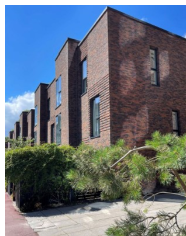
Eksempel på relief og forskydninger i facaden.
