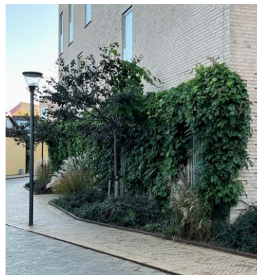
Eksempel på grøn facade samt grøn kantzone.
