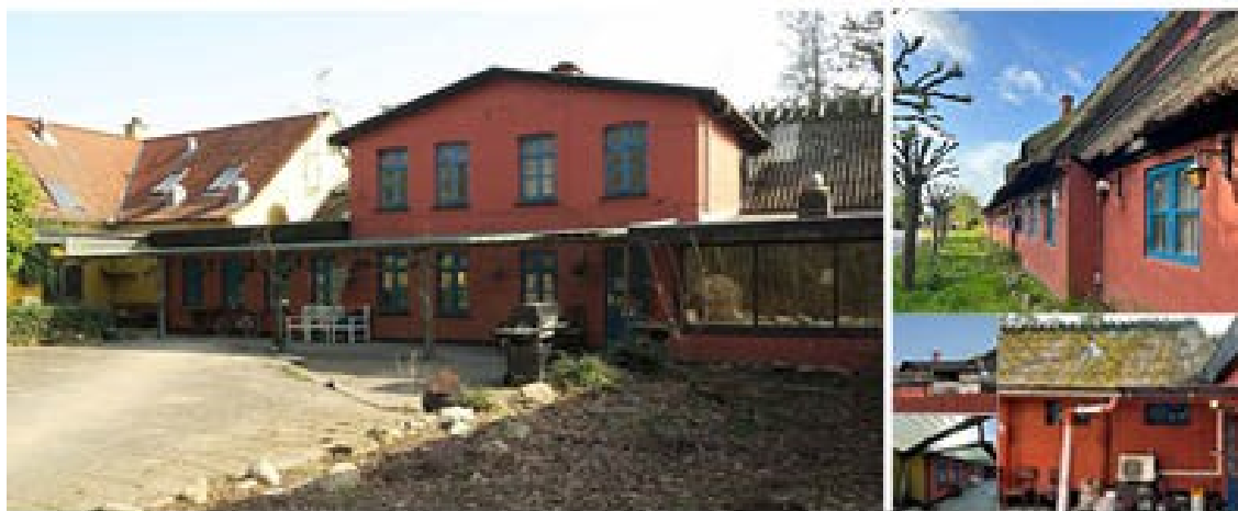
Den gamle gårdbygning mod nord og gårdrummet – Tidens vinduer mødes med nutidens – Diverse sammenbygninger – Byggeri efter behov - Sammenbygning
