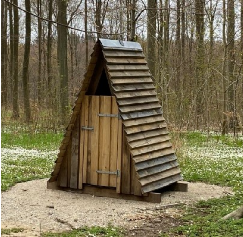
Figur 2: Billede af udformning af det primitive toilet. Billedet er taget af Naturstyrelsen og vedlagt ansøgningen.
