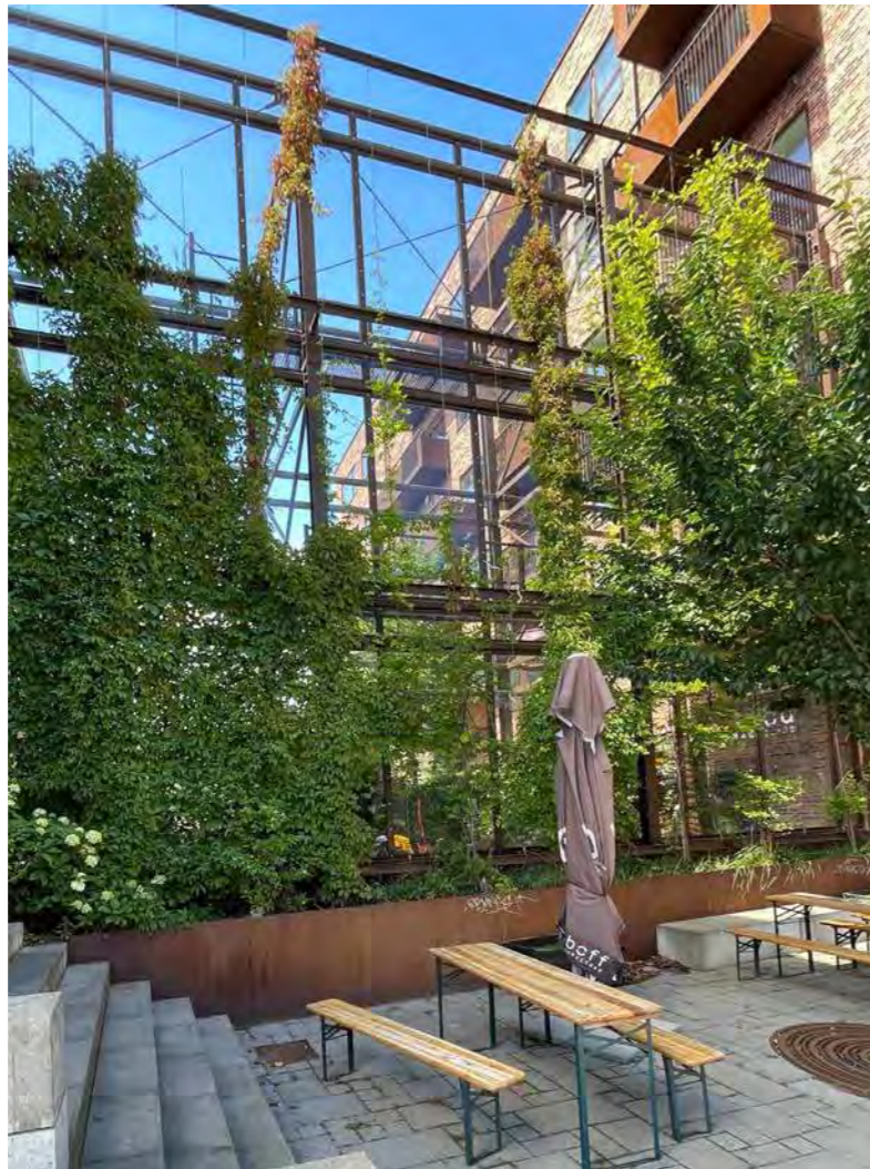
Grøn støjafskærmning mellem en trafikeret vej og et gårdrum
