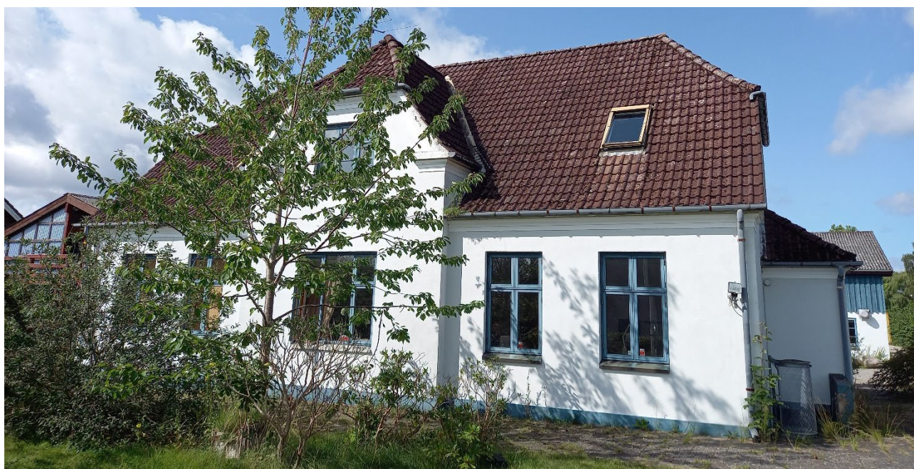
Hovedhusets facade mod øst
