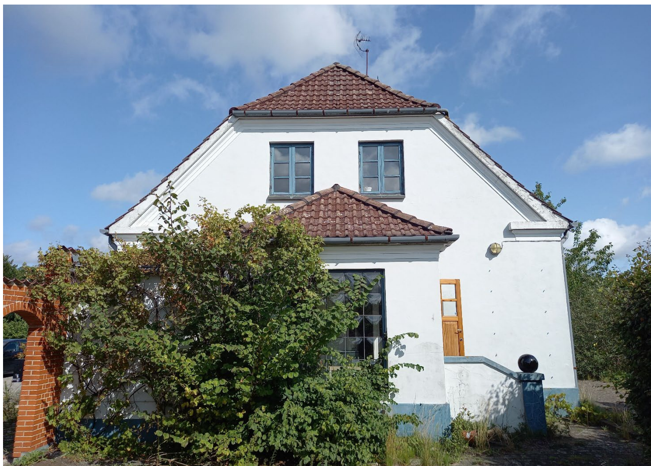
Hovedhusets gavl mod nord
