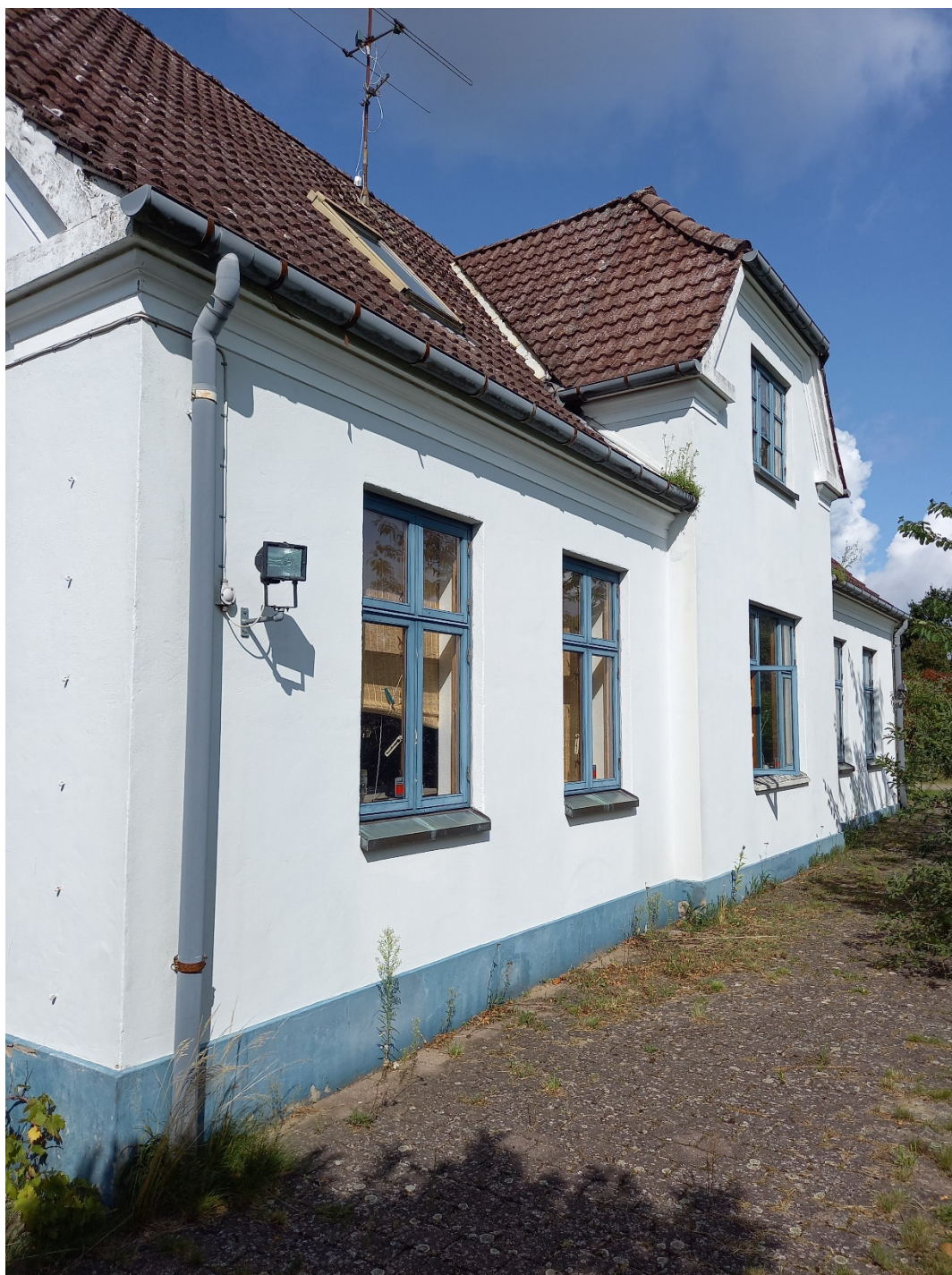
Hovedhusets facade mod øst.
